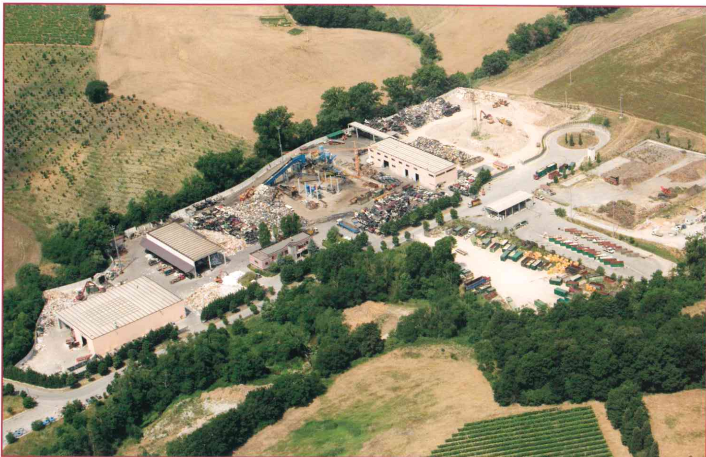
Sopra: veduta aerea degli impianti
